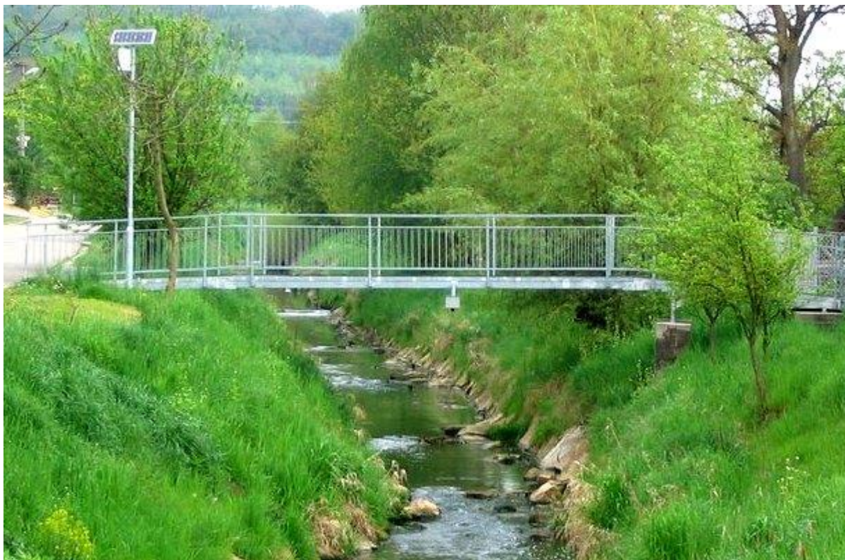
Příklad instalace vodoměrné stanice s ultrazvukovou sondou (napájení solárním panelem)
