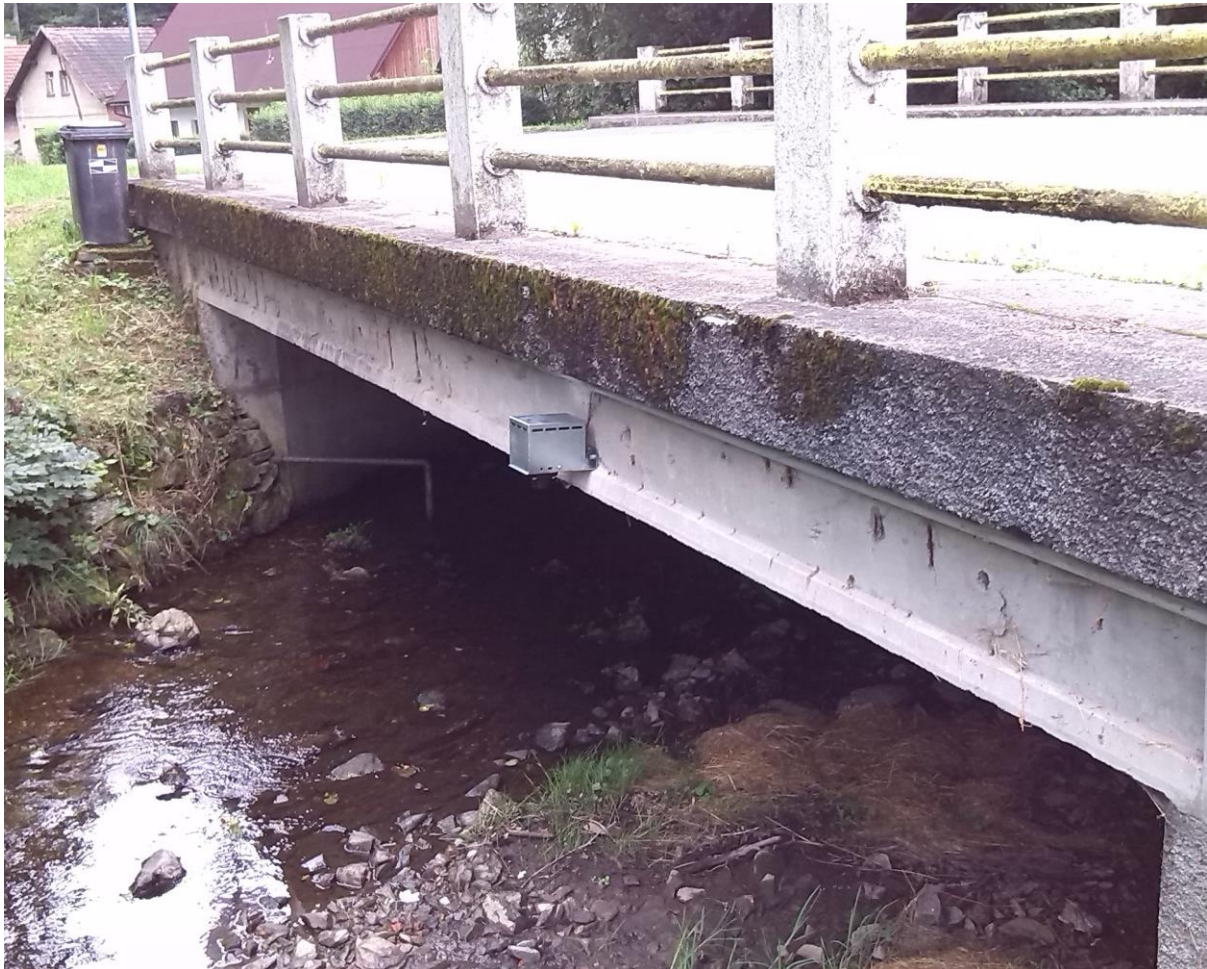
Příklad instalace vodoměrné stanice s ultrazvukovou sondou
