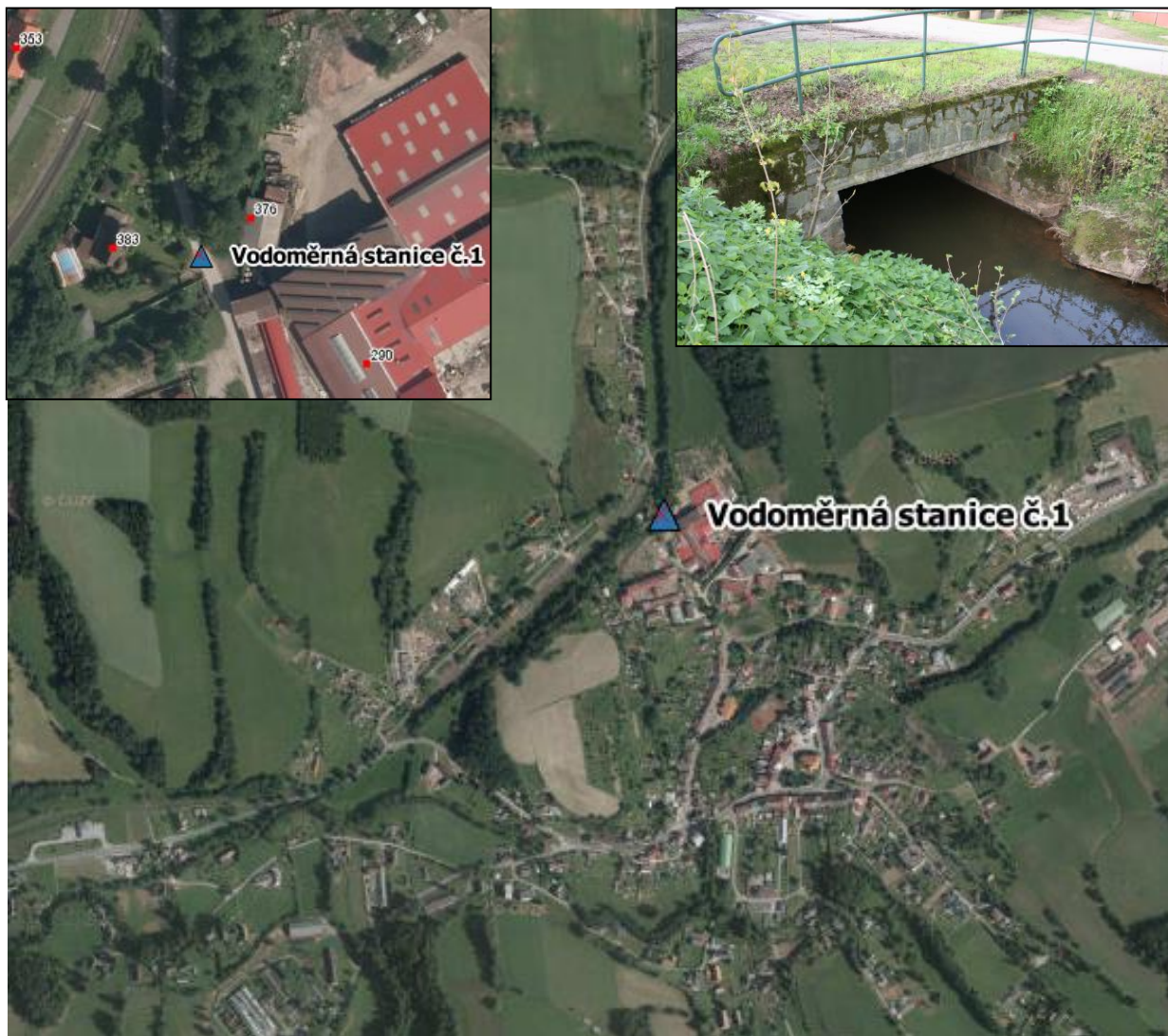
Umístění vodoměrné stanice č. 1 ve městě Pilníkov
