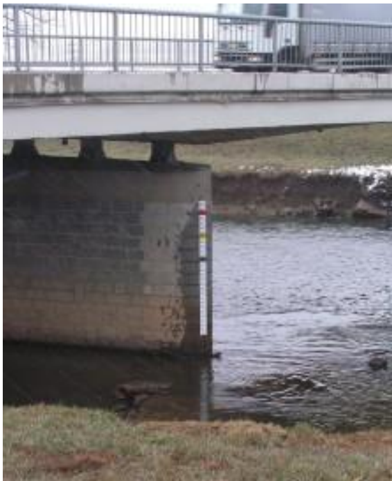
Příklad instalace vodočetné latě
